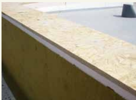
Atika byla zaizolována extrudovaným polystyrenem tl. 120 mm, na nosný podklad z OSB desek jsou osazeny nové plechy
