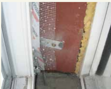
Nová okna byla vysazena před obvodový panel na ocelové kotvy tvaru písmene T 180/180 mm po 400 mm. Současně s výměnou oken se vyměnily i vnitřní a venkovní parapety a provedlo se vnitřní zednické zapravení, byly osazeny utěšňující pásky a krycí lišty.
