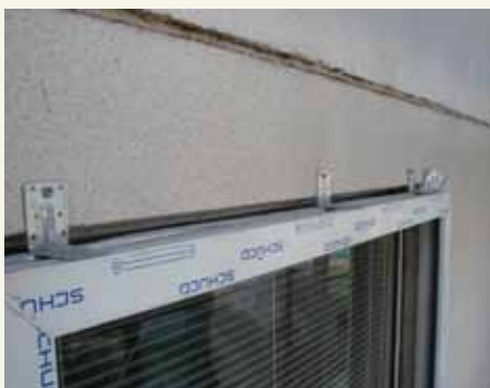
Nová okna byla vysazena před obvodový panel na ocelové kotvy tvaru písmene T 180/180 mm po 400 mm. Současně s výměnou oken se vyměnily i vnitřní a venkovní parapety a provedlo se vnitřní zednické zapravení, byly osazeny utěšňující pásky a krycí lišty.
