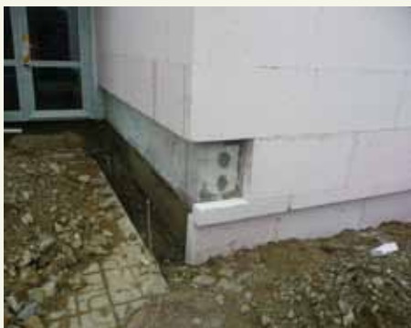
Izolace soklové části byla zapuštěna 600 mm pod úroveň upraveného terénu
