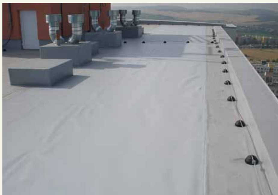
Střecha je zateplena dvěma vrstvami izolantu
