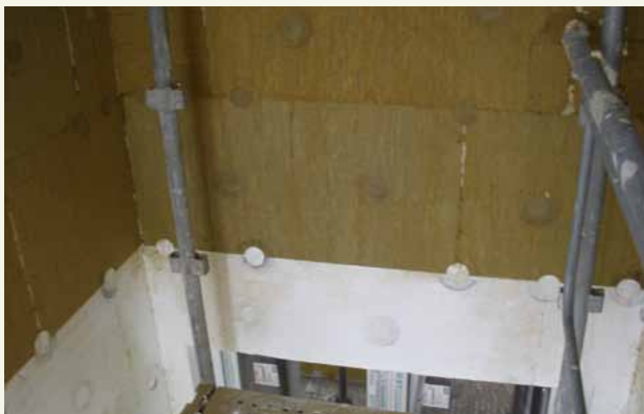
Zateplení obvodového pláště – zavrtávací kotvení hmoždinky byly zapuštěny do izolantu a utěsněny ucpávkou. Nad vstupy je minerální vata tl. 200 mm.
